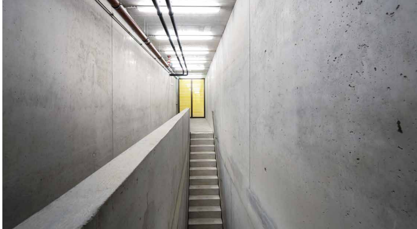
Alle Betonoberflächen im Innenbereich sind unbehandelt.
